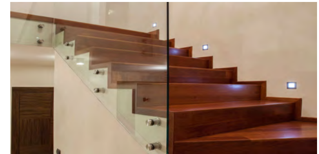
Barandas con distanciadores
