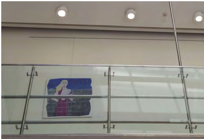
Columnas con distanciadores
